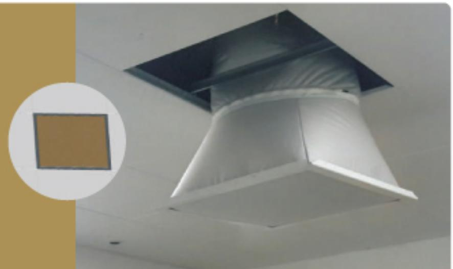
หมายเหตุ : Insusox<sup>®</sup> สามารถใช้งานกับช่องจ่ายลมเย็บสังกะสีแบบเดิมได้ เช่น กับ
