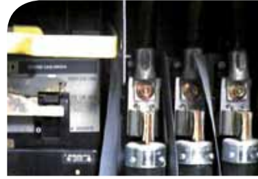
Elektrik kontaklarını görmektesiniz.
